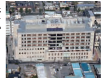
館林厚生病院新病棟(航空写真)
