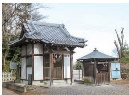
平成6年3月に町道幹線6号線拡幅のため、旧社地から現在地に遷座された大国神社
