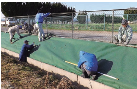
防草シート（幅2m）を100mにわたり張りました。 50m張るのに約3時間は、かかったといいます
