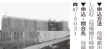
建設が進む石打町営住宅A棟 住所▶邑楽町大字石打1171-1 建物▶鉄筋コンクリート造3階建て
