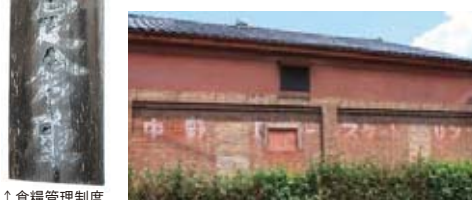
↑倉庫の南側、東側、西側には雨どいを支える金具が残っています。金具の配置からノコギリ屋根があったことの証明のひとつとなっています ↑南側レンガ壁には「中野ローラースケートリンク」の文字が今も見えます。昭和27年ごろ、スケートリンクとして活用されていた痕跡が残っています
