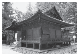
日光東照宮奥社拜殿・正面側面全景(建築時期は、世良田東照宮の拜殿より十数年ほど下る)
