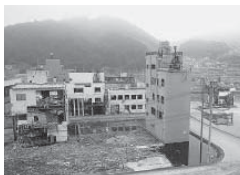
←被災地宮城県女川町。津波に飲み込まれた町は、がれきの山と化していました
