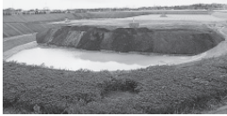
基準値以下の測定結果で埋め立てが継続可能な埋め立て最終処分場のようす
