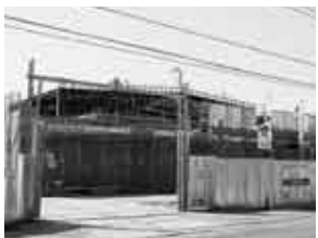
現在、建設工事が進んでいる学校給食センターは、第2学期から配食を開始する予定です
