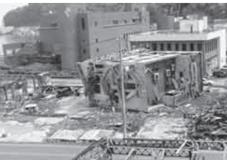
女川町の漁港も地震による津波で、壊滅的な打撃を受けた。震災のすさまじさが改めてうかがえる
