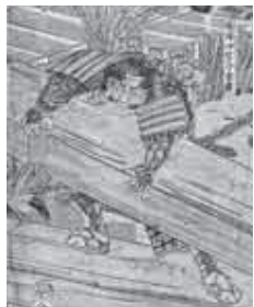
重広は「卒塔婆を立てるも、橋を渡すも功德は同じ」と言つて、大卒塔婆を引き抜いて橋を架けたといひます。当時、橋を勸進(寄附)するのは、大きな功德だった。
