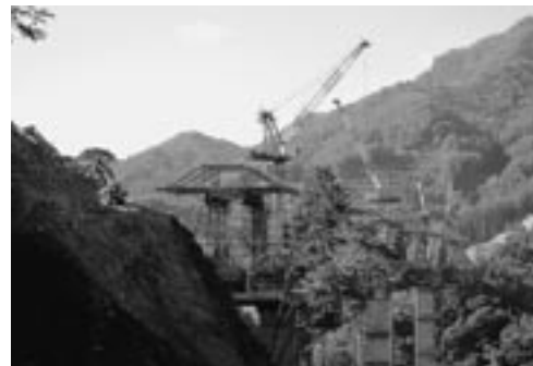
工事が中断している八ツ場ダム
