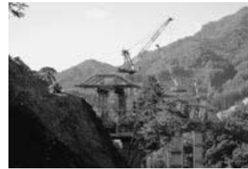
工事が中断している八ツ場ダム
