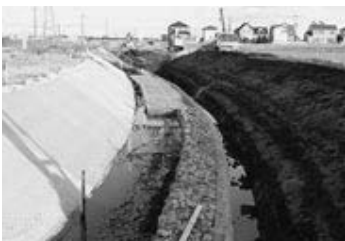
現在、二ツ橋東側の堤防を整備しています
