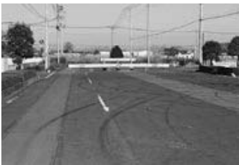
現在、新堀川手前で行き止まりになっています
