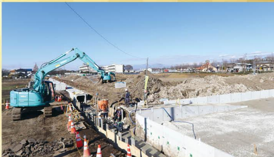
今年秋ごろの竣工に向け施行中の生活拠点整備の現場(邑楽南中学校東)
