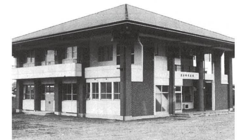
建設当時の写真(広報おうら昭和55年4月号より)
