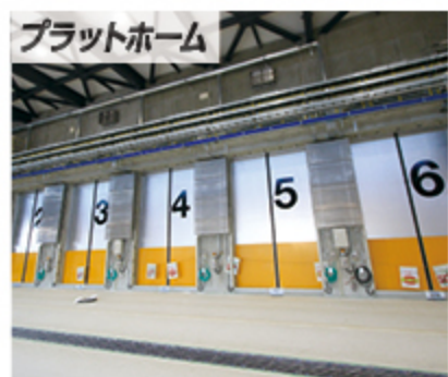
プラットフォーム ごみ収集車で地区内から集められたごみが、ゲートを介してピットに投入されます。ゲート数は自己搬入用を含めて全部で7つ
