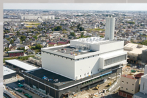
太田市細谷町地内に建設中のクリーンプラザ
