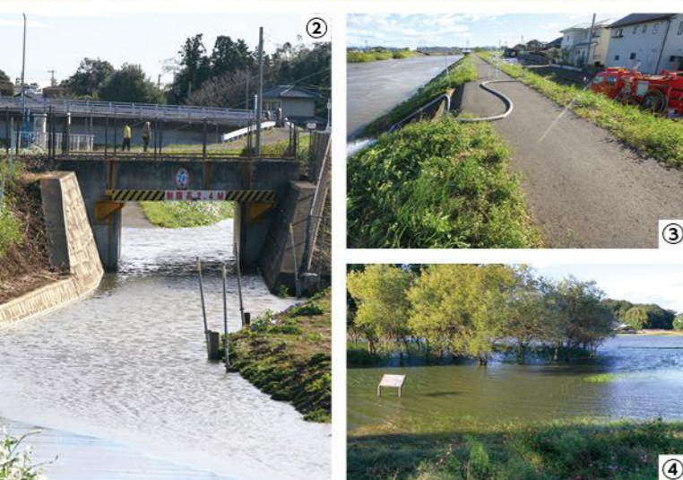
【台風19号から一夜開けた朝のようすから見る町の状況】 ①坪谷地内では田んぼにたまった雨が水位が下がった川に流れこんでいた ②鶉地内では矢場川に流れ込めなくなった排水が逆流し、道路などが冠水 ③消防団の車両がたまった水を川に排水していた ④役場南の中央公園の調整池は本来の機能を果たし、遊歩道が見えなくなるくらい水をため込んでいた
