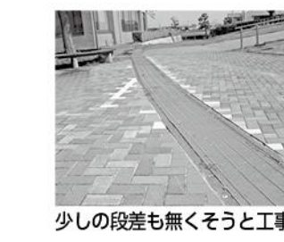
少しの段差も無くそうと工事
