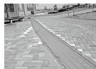
少しの段差も無くそうと工事
