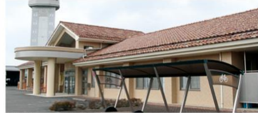
支援センターは保健センター内に設置されています
