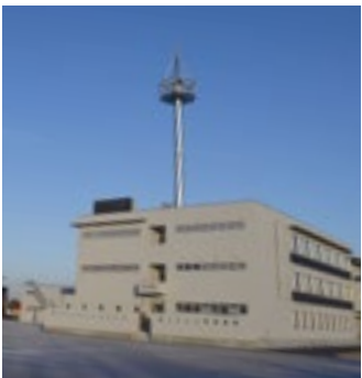
完成した3階建ての新庁舎
