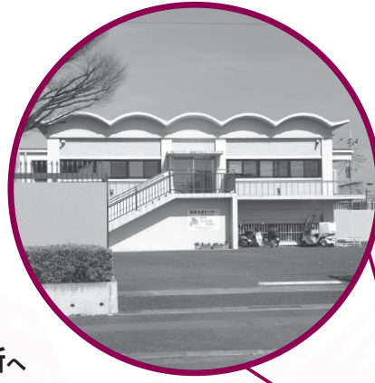
群馬東部水道企業団 館林支所 (館林市広内町3-10)
