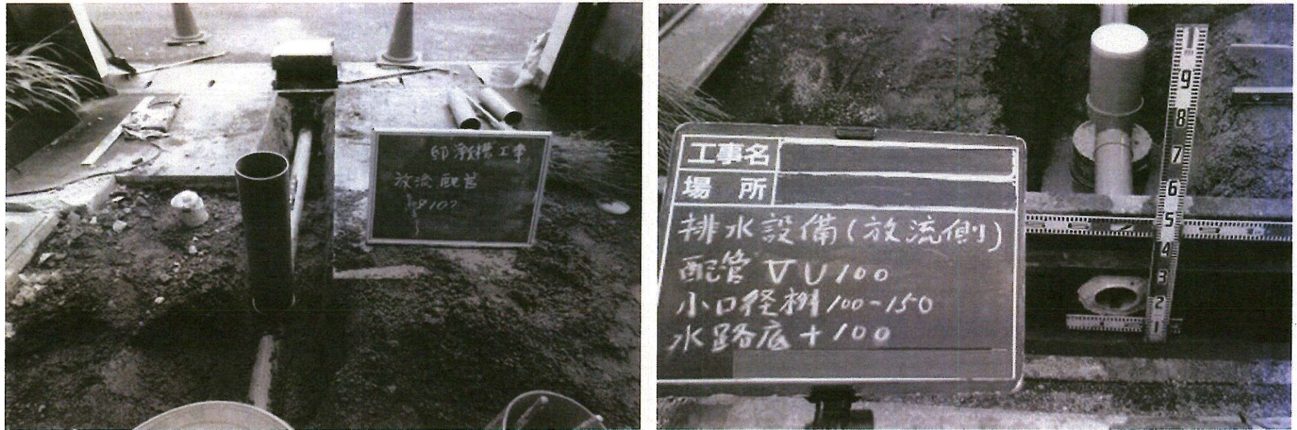
写真(放流先接続状況)
