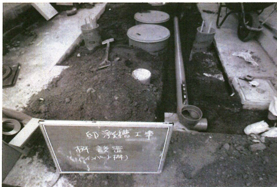
写真(宅内配管設置状況)
