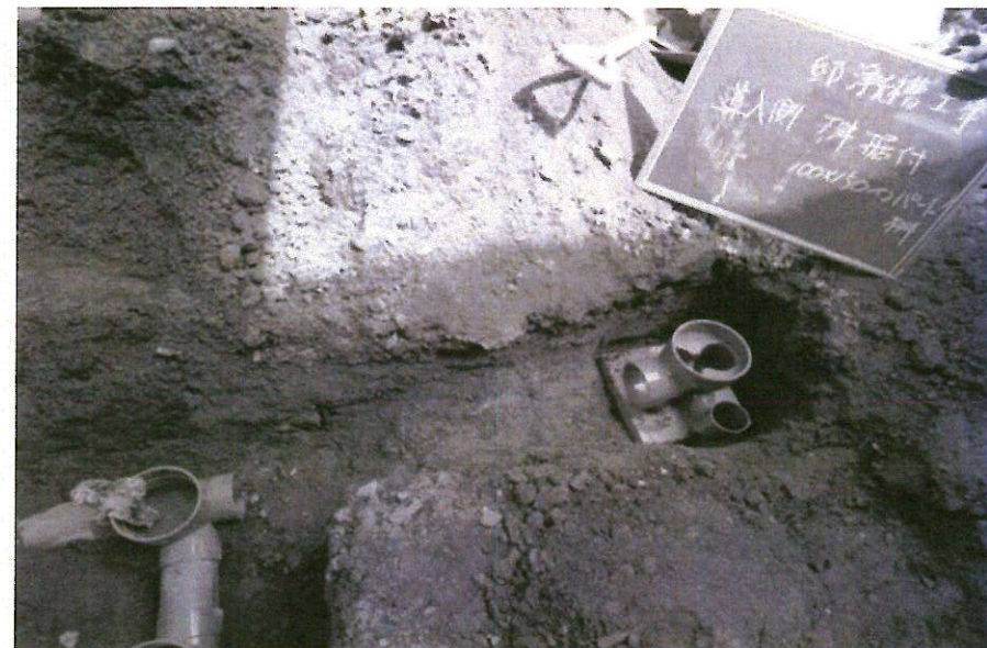
写真(宅内配管設置状況)
