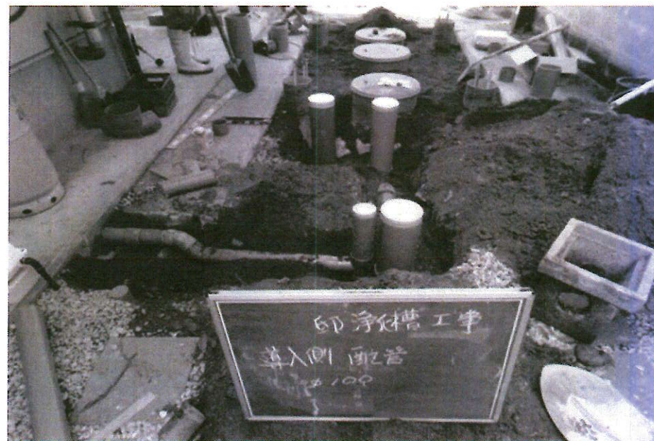
写真(宅内配管設置状況)
