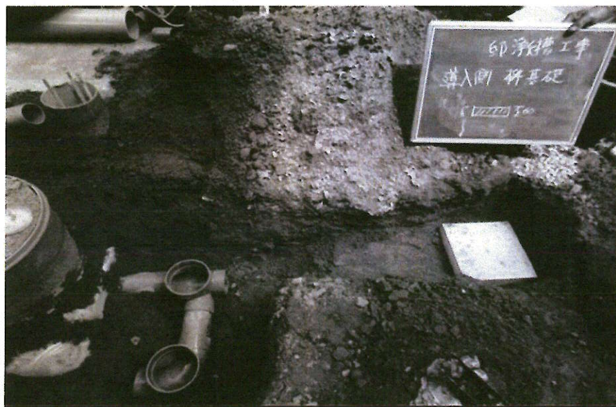
写真(宅内配管設置状況)
